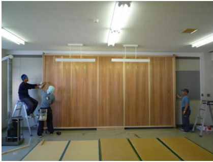
能楽室に仮設置
